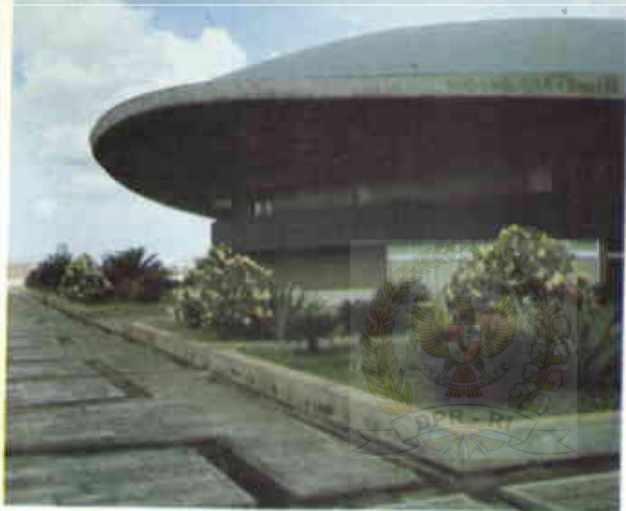
Taman disebelah kanan ruang pleno.
