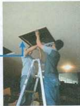
Gambar pemasangan bingkai lampu LED panel ke plafon
