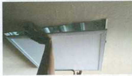
Gambar pengujian pemasangan lampu LED panel ke plafon
